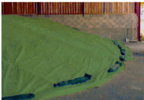
(6) fixer avec des sacs de sable
